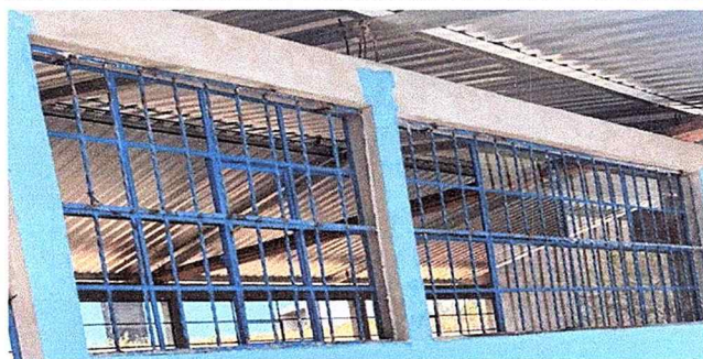
Foto 5: colocacion de ventana 2
