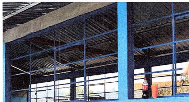
Foto 4: Colocacion de ventana 1
